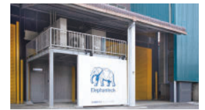
Shinkiba R&D Center (Koto-ku, Tokyo)
